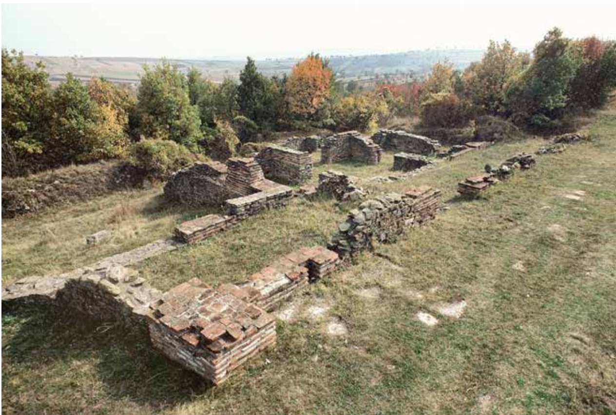
Грађевина југоисточно од Трга-поглед са северозападне стране, 1977. (снимио Небојша Борић) Building southeast of the Square - view from the northwest side, 1977 (photo by Nebojša Borić)
